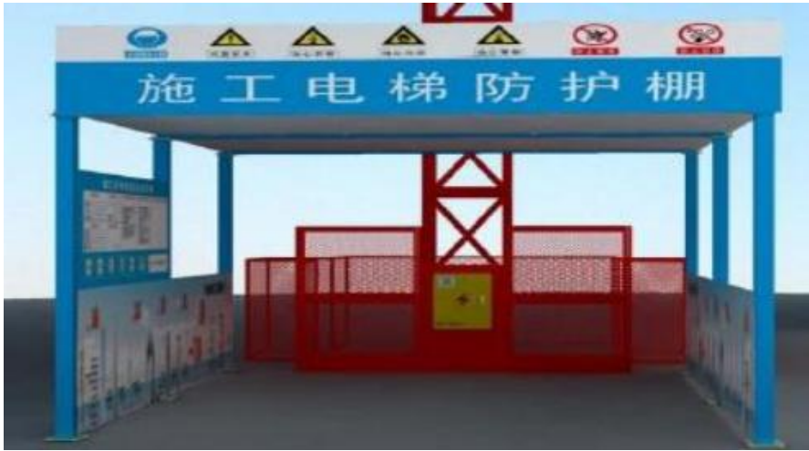
定型化安全通道（施工电梯防护棚）
