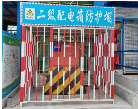
配电箱防护棚
