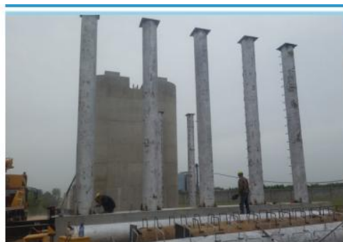
钢管柱安装
