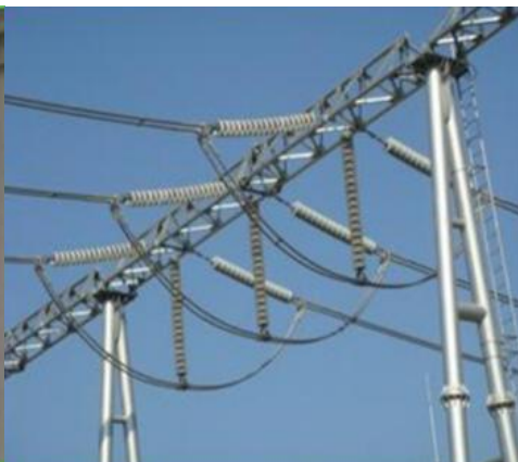
图 3-2 软母线跳线
