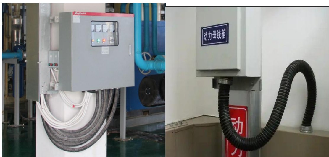
图 12-2 金属软管敷设
