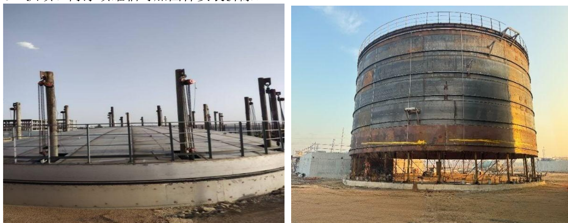
储罐倒装法施工
